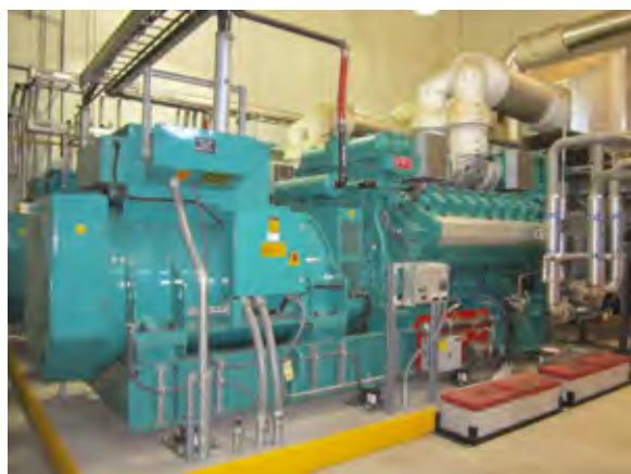
Два газопоршневых электрогенератора Cummins на натуральном обедненном газе обеспечивают энергоснабжение в резервном режиме на территории университета штата Вашингтон в США.
